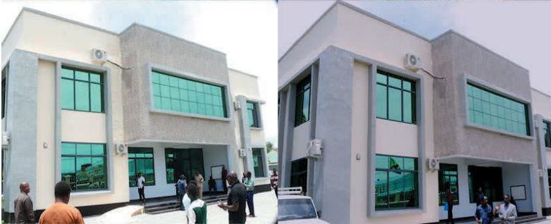
Picha Na. 9: Baadhi ya Vituo vya Umahiri kati ya Vituo Saba Vilivyojengwa katika Mikoa Mbalimbali Nchini
